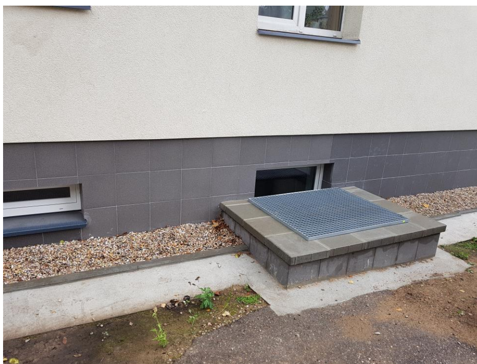
Світлина 5. Приклад облаштування відмостки з підземним дренажем
