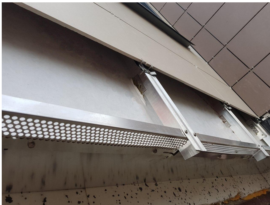
Світлина 2. Елементи вентиляваного фасаду будівлі
