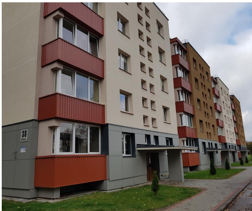
Світлина 7. Облаштування та утеплення балконів з приведенням до єдиного архітектурного вигляду
