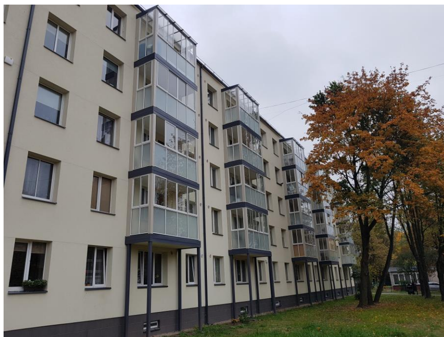
Світлина 6. Облаштування прибудованих світлопрозорих балконів до суцільної фасадної системи
