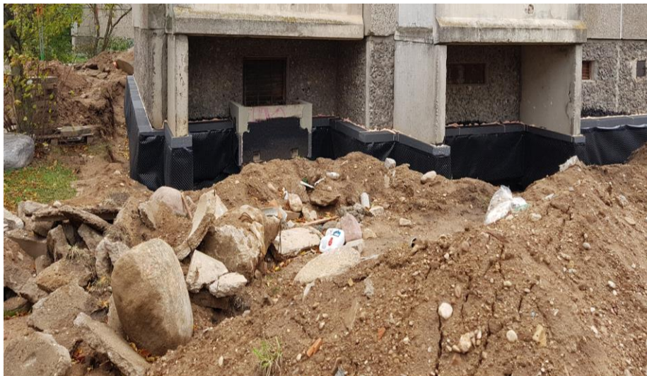
Світлина 4. Облаштування теплоізоляції стін нижче рівня ґрунту
