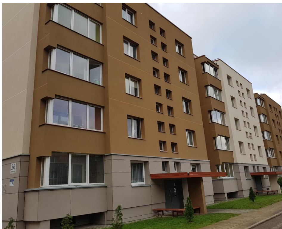
Світлина 9. Облаштування комбінованої фасадної системи з опорядженням штукатуркою та керамічними плитами (перший поверх) та суцільним утепленням непрозорих огорожень балконів
