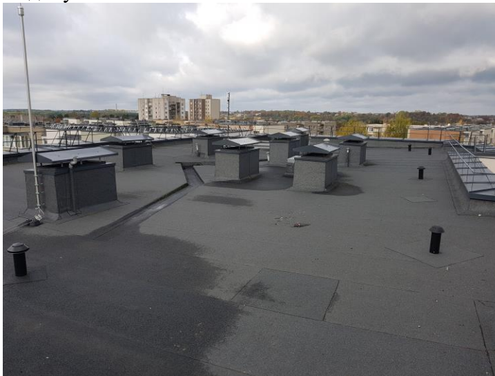
Світлина 13. Облаштування утеплення сумішеного покриття з вентиляційною системою типу W-5
