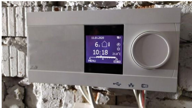
Світлина 3. Електронний регулятор (блок управління)
