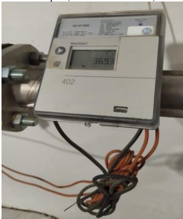
Світлина 2. Тепловий лічильник (обчислювальний блок)
