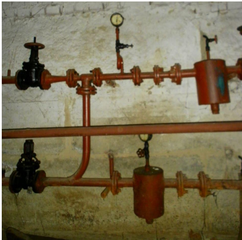
Світлина 1. Типовий вузол вводу теплової мережі системи опалення з гідроелеватором
