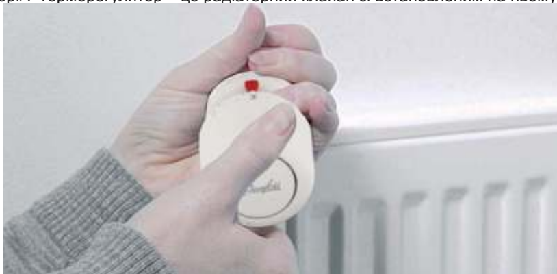
Рис. 8. Автоматичний радіаторний терморегулятор прямої дії
